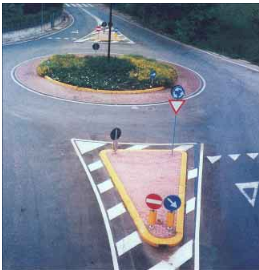
Figura 6-18 – Esempio di posizionamento della segnaletica verticale ed orizzontale [6].
