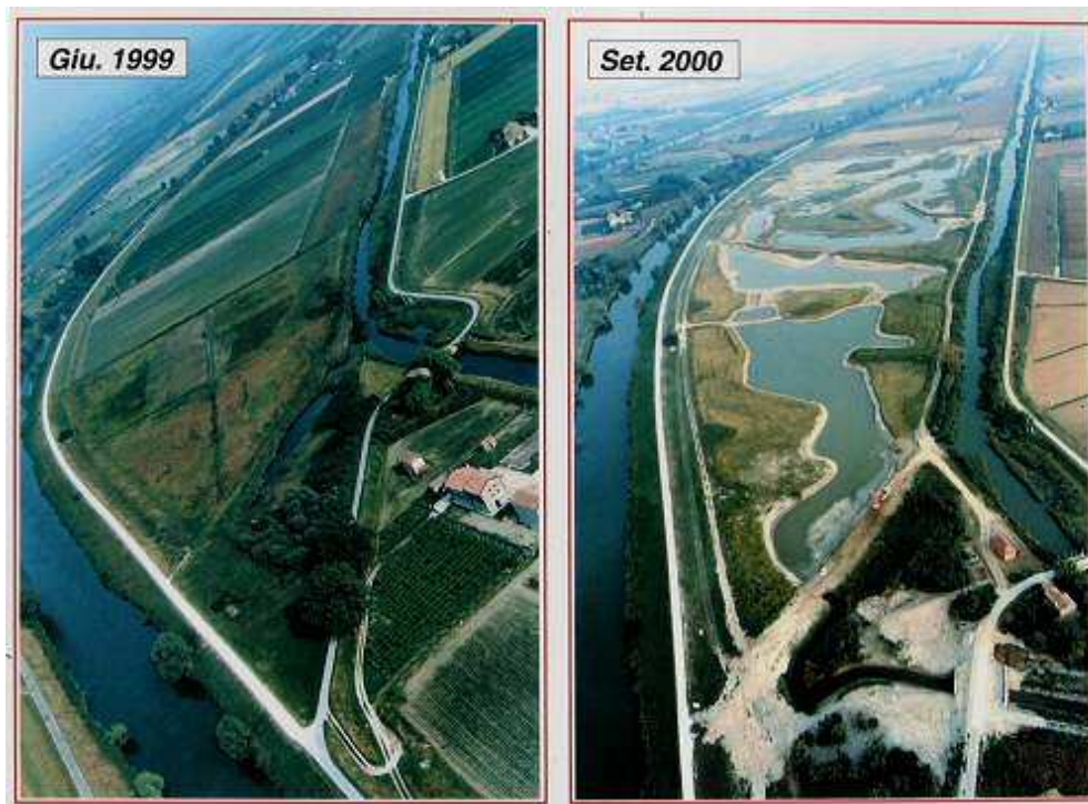
29. Bacino di fitodepurazione di Cà di Mezzo
